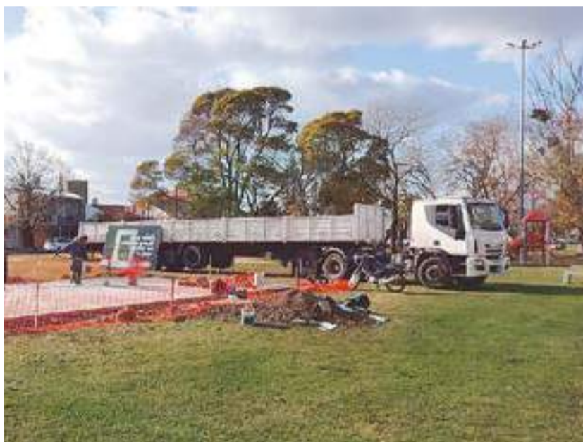
El cemento avanza sobre la 32/532
